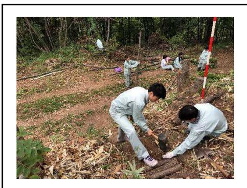
展望台まで人が登頂できるよう、一部山道の狭い箇所があるため、別に散策路を設けることにした。幅広い年齢層が利用することを考え、階段の段差は小さくし、階段付近の土砂が降雨などで流されないよう伐採した木を用いて写真のように施工した。手すりも併せて設置したほか、人と車が分けて通るよう案内標識なども散策路の周辺に設置した。
