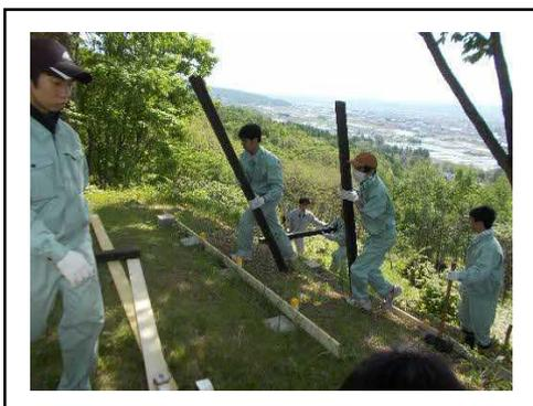
搬入した資材をもとに急斜面での設置作業を行った。張出した構造になっているため、平面での設置時に比べ安定性を欠いており、耐久性の面で課題が多く残った。課題解決に当たり地元企業の協力を得て、補強箇所について検討を行い、材料を追加して逃げ杭を施工した他、補強材を斜面側に配置し、安定させることができた。
