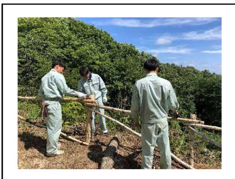
初めて登頂する人のことを考え、危険箇所や経路などを検討した結果、山道の一部に安全柵を設けることにした。展望台周辺も滑落の恐れがあるため併せて施工を行うこととした。また柵周辺には、危険を知らせるための看板を設置している。その他にも一定間隔毎に休憩できるようにベンチやテーブルを設置しており、安心して散策ができるよう工夫を凝らしている。
