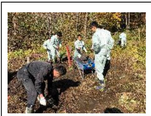
池造成地を検討するのに時間を要したため、前段の大型機材投入の時期とは合わず、池の造成は手堀で行うことになった。傾斜地での作業となったため、池の底面の高さを揃えて掘削することとし、掘削量が予定を大幅に越えて作業が長期化してしまった。来年度は、作業を見通し、機械の導入に合わせて色々な作業ができるようにする必要がある。
