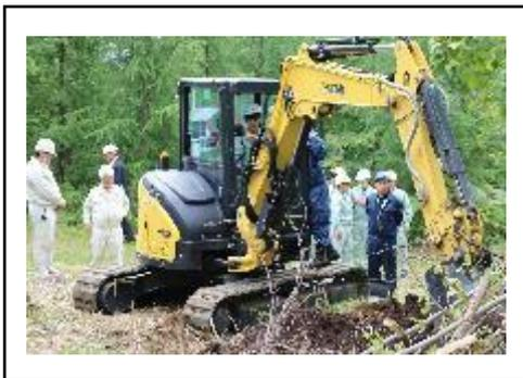
池の造成予定地までの道路が、河川の流入によって洗掘されていたため、河川を付け替えた上で埋め立てし、道路を拡幅する工事が必要となった。人力で作業をするのが困難であったため、建設機械を用いることにした。
